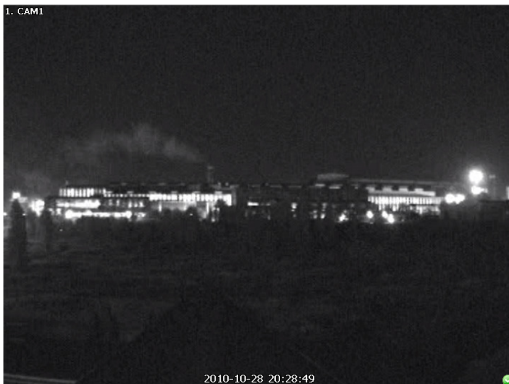
Bild 1: Der Abgasstrom des höchsten Schornsteines (E3) erreicht den Erdboden direkt nach dem Hallengebäude. Der Abgasstrom strömt direkt auf Menschen ein.
