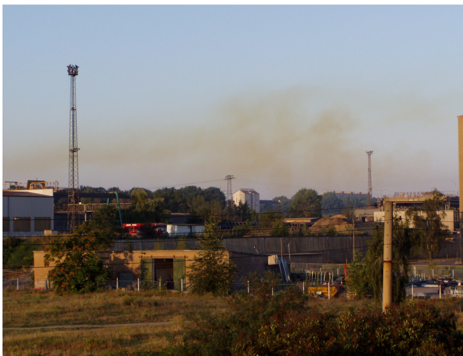
Bild 8 Staubwolke fliegt ins Wohngebiet direkt in die angrenzenden Gärten
