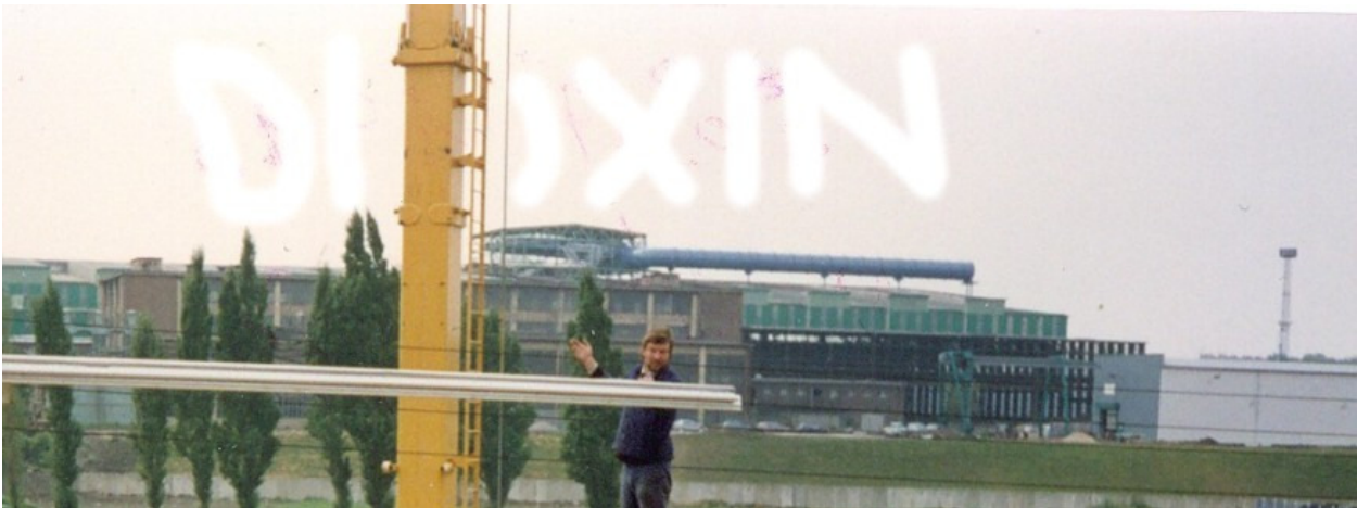
Bild 1 Zeigt im Hintergrund den Bau der Abgasleitung des Elbe Stahlwerkes Riesa im Sommer 1993
